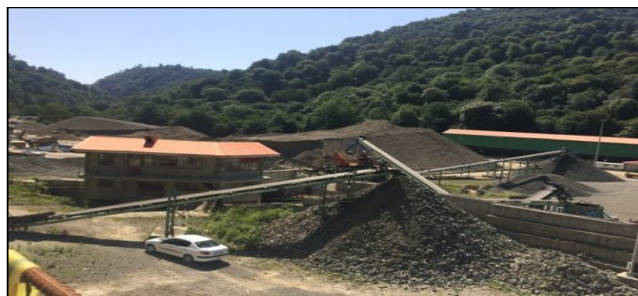
شکل ۱۲: عملیات ساختمانی و تغییر در بستر و دامنه‌های دره‌های مشرف به شفارود
