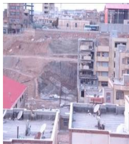
شکل ۵- نمونه ساخت‌وساز روی سازندها با لیتولوژی نامقاوم و منفصل که در ترانشه ایجاد شده تناوب مارن‌های آهک‌دار و ماسه سنگ با میان لایه‌های آهکی مشهود است.
