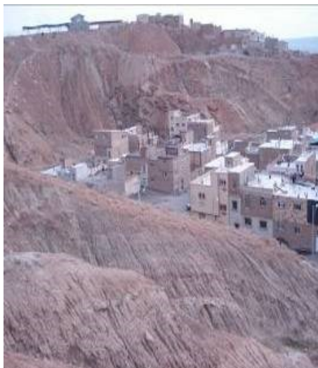
شکل ۴- نمونه ساخت‌وساز در دامنه تپه‌های منفرد مارنی و رسی با شیب تند و در معرض خطر ناپایداری کامل دامنه‌ای
